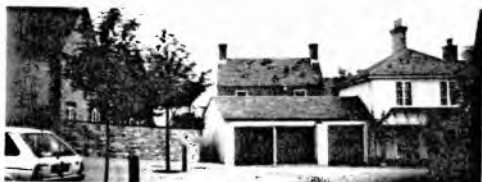
Unutrašnja dvorišta sa parkinzima su rešena kao atraktivni prostori, koji se dobro sagledavaju iz okolnih objekata
